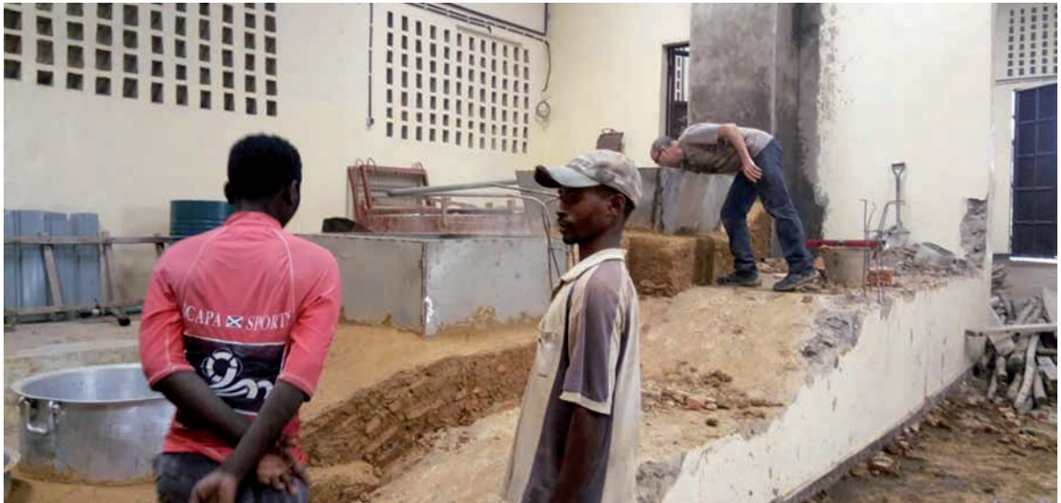
Instal·lacions de la "Sucrera de Sant Josep" de Rubare.
